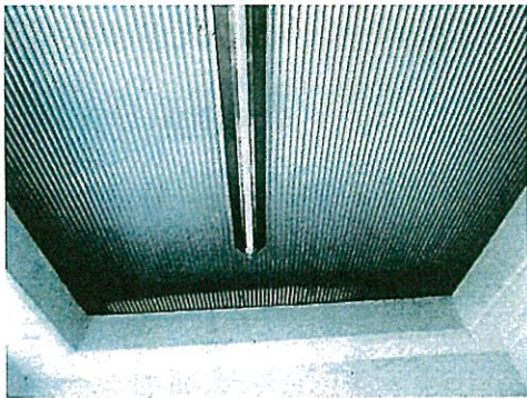
トイレ内天井蛍光灯（昼間消灯）
